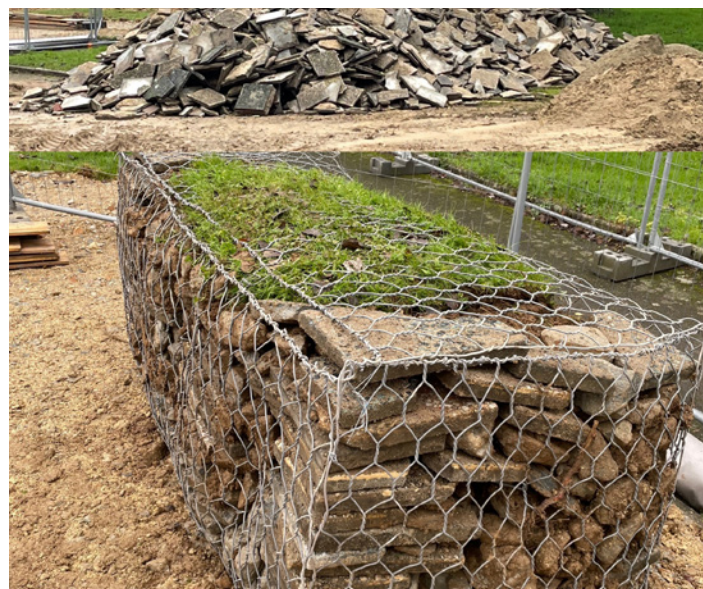
Projet de médiathèque et tiers-lieu en structure bois-paille à La Chapelle-Thouarault (35) Réemploi de dallage en gabions - Projet de requalification urbaine Bourny I à Laval (53)
